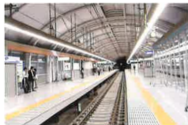
日暮里駅 総合改良事業工事
