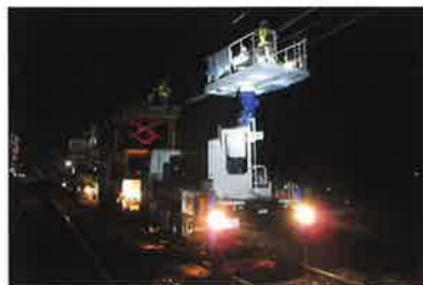
志津～ユーカリが丘間他電車線張替工事
