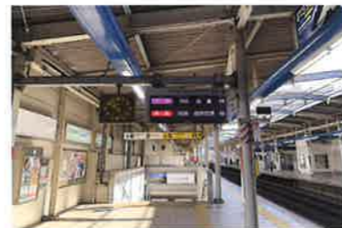
案内表示器更新工事
